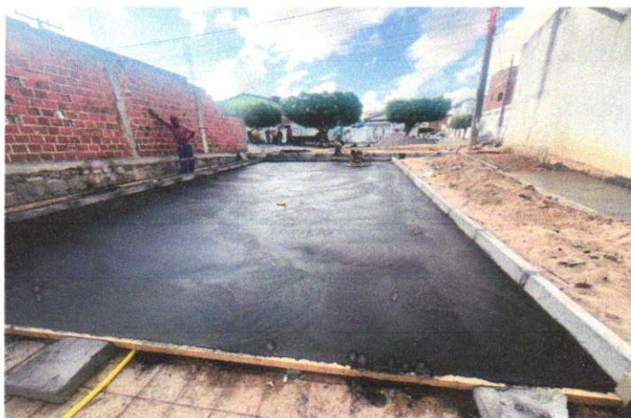
FOTO 19 -PAVIMENTAÇÃO EM CONCRETO, COM ESPESSURA DE 7 CM, COM ACABAMENTO FEITO UTILIZANDO ALISADORA DE CONCRETO (HELICOPTERO), INCLUIDO TELA DE AÇO SOLDADA NERVURADA CA60
