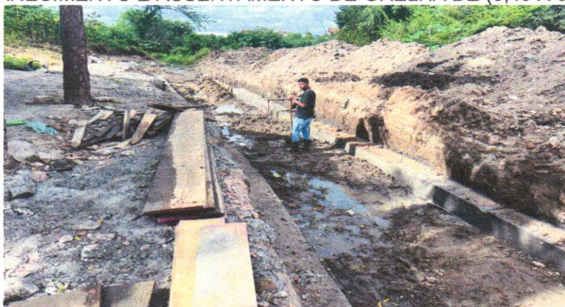
FOTO 08 -ESCAVAÇÃO MANUAL DE VALA COM PROFUNDIDADE MENOR OU IGUAL A 1,30 M
