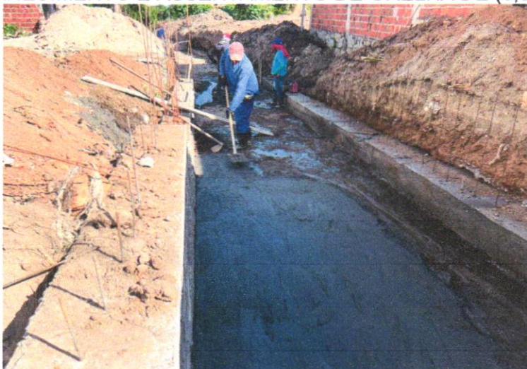
FOTO15 -ESCAVAÇÃO MANUAL DE VALA COM PROFUNDIDADE MENOR OU IGUAL A 1,30 M
