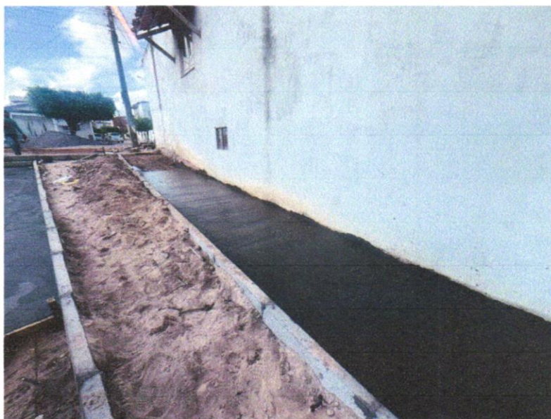
FOTO 01 - PAVIMENTAÇÃO EM CONCRETO, COM ESPESSURA DE 7 CM, COM ACABAMENTO FEITO UTILIZANDO ALISADORA DE CONCRETO (HELICOPTERO), INCLUIDO TELA DE AÇO SOLDADA NERVURADA CA60
