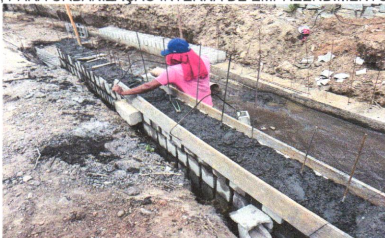
FOTO 10 -LASTRO DE CONCRETO, E=5CM, PREPARO MECÂNICO, INCLUSOS LANÇAMENTO E ADENSAMENTO
