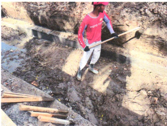
FOTO 17 -ESCAVAÇÃO MANUAL DE VALA COM PROFUNDIDADE MENOR OU IGUAL A 1,30 M
